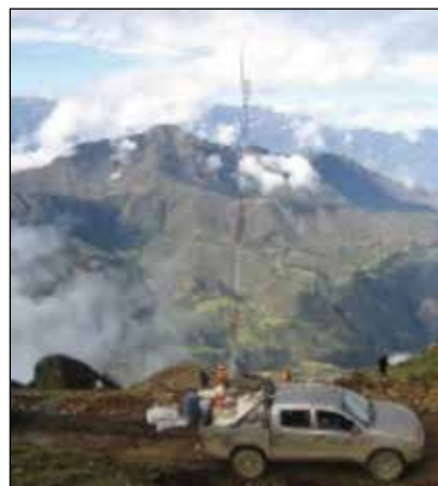
Figure 8 : Protection foudre d'un site minier au Pérou.
